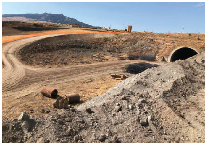
Imbocco galleria Paravola, Mistretta: fasi propedeutiche alla ripresa dei lavori.
