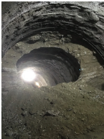
Metropolitana di Milano, prolungamento della linea 1: sfondo della prima galleria naturale.
