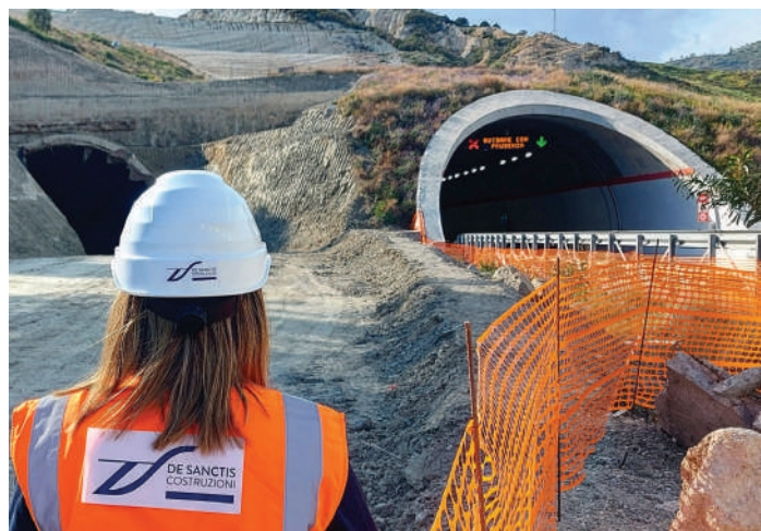
Reggio Calabria, galleria Sant'Antonino – imbocco Taranto.
