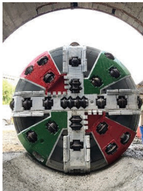
TBM all'imbocco nord della galleria San Sebastiano (Chieti).
