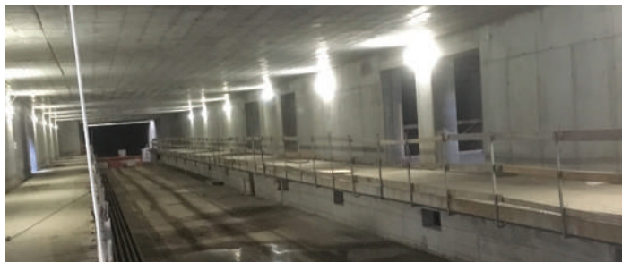
Metropolitana di Milano, prolungamento della linea 1: rustici di galleria di stazione.
